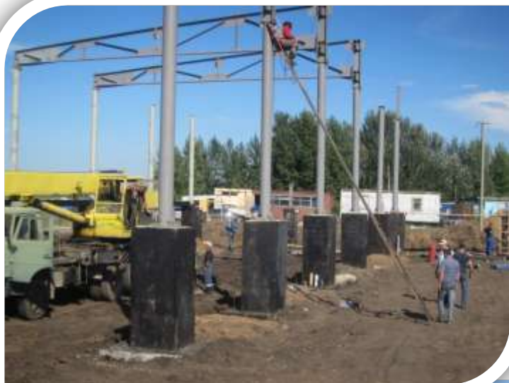
Монтаж металлоконструкций.
