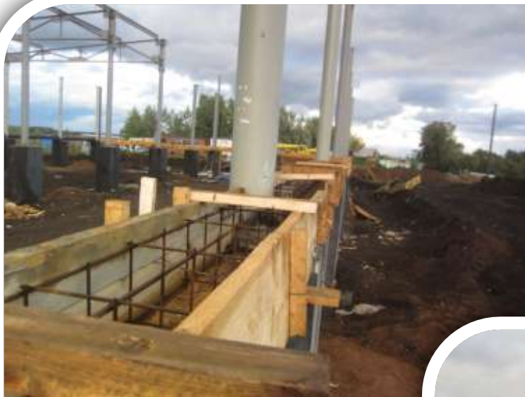
Заливка фундаментной балки
