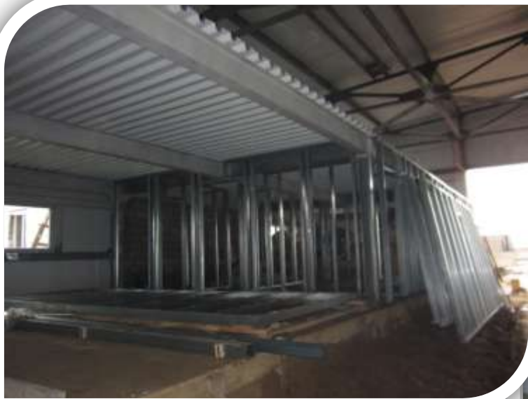
Возведение помещений АБК.
